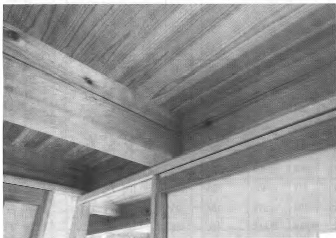
燃えしろを考慮した150mm角の梁
