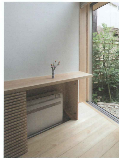
写真3 空調の暖気を床下に 床置き型のエアコンを床より低い位置に設置。冬は床材がほんのり暖まって快適だという
