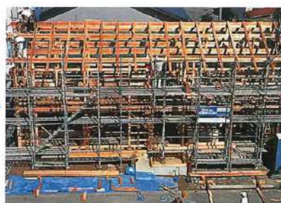
写真5-2 副架構の小屋組が置かれる
