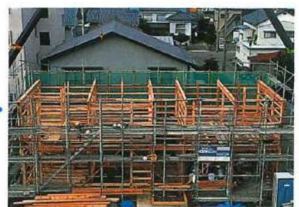
写真5-1 主架構の門型フレームが建てられる
