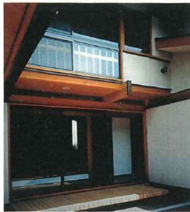
写真8 江古田の家。内庭から外観を見る
