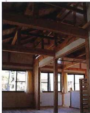
写真7 横浜・二俣川の家。1階みんなの間から吹抜け部の架構を見る
